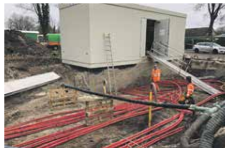
Nieuwe ondergrondse kabels naar het trafostation in De Slieten
