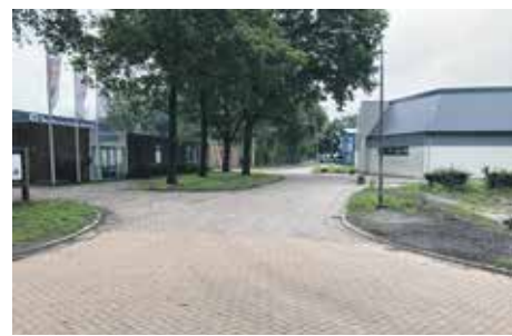
In De Slieten is niets meer te zien van de vele kabels onder de verharding
